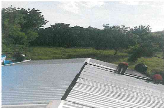
Foto 5: Instalación de 80 metros de lámina nueva troquelada calibre 26
