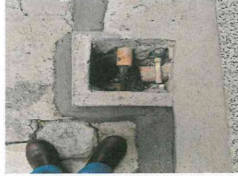
Foto 2: Sustitución y colocación de nueva tubería de la pila.
