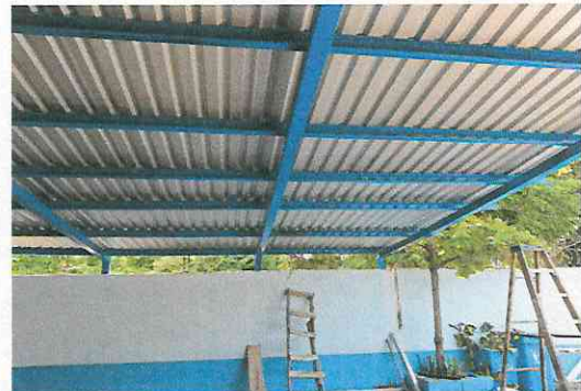
Foto 6: Instalación de estructura metálica y techo de lámina troquelada calibre 26 patio del establecimiento
