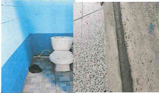
Foto 3: sustitución y cambio de tubería de tanque a los baños.
