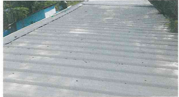
Foto 4: Levantamiento de 300 metros de lámina corrección de traslape e instalación nuevamente.
